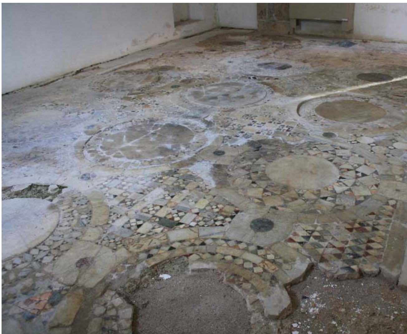
Fig. 75 Veduta del pavimento dal fondo del muro nord. La soglia d'ingresso è a destra
